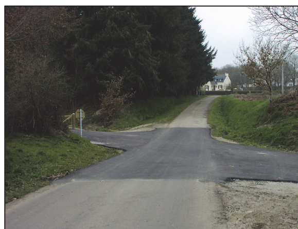
Photo ② : Prolongation de l'enrobé sur la voie traversée
