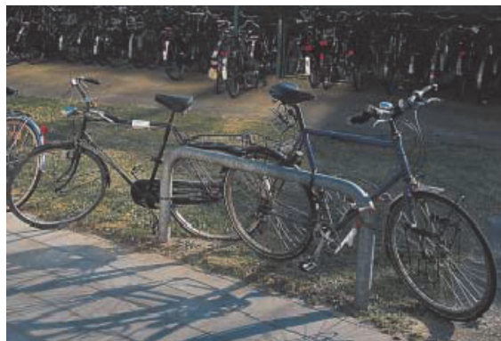
Arceau trop large et trop bas : les vélos se gênent et s'abîment
