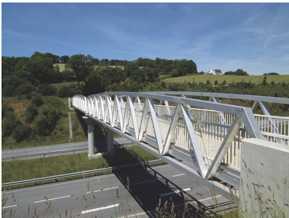
Passerelle – Contournement nord-ouest de Quimper
