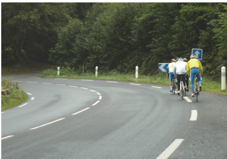
Accotements revêtus - RD 765 à Quimper
