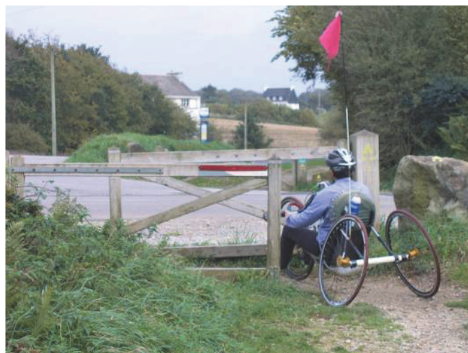
Passage d'un handbike impossible (barrières trop serrées)
