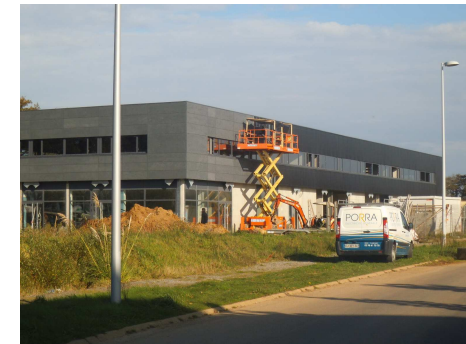
Construction de la crèche Babilou et du restaurant L'Escale (octobre 2014)
