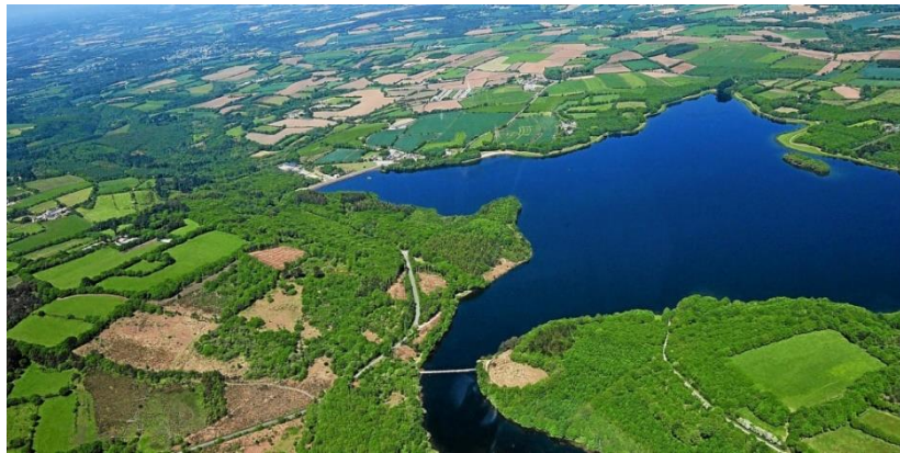
Ci-dessus : retenue d'eau du Drenec, permettant la gestion de l'étiage de l'Elorn,
