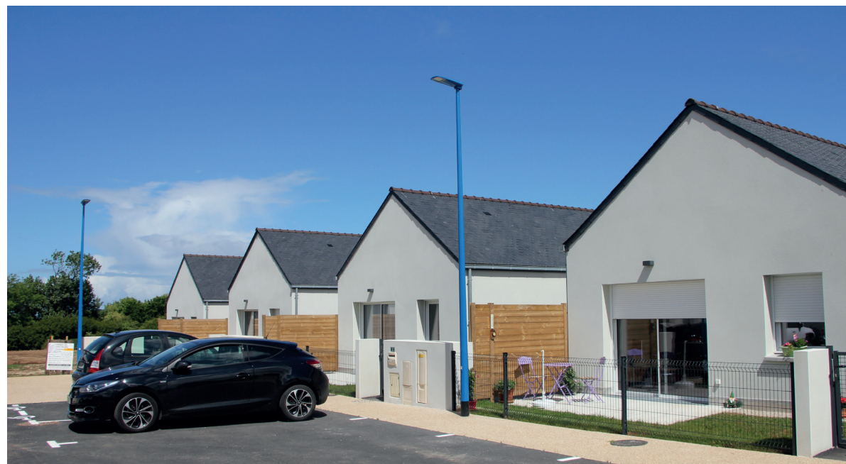
Réalisation des logements séniors
