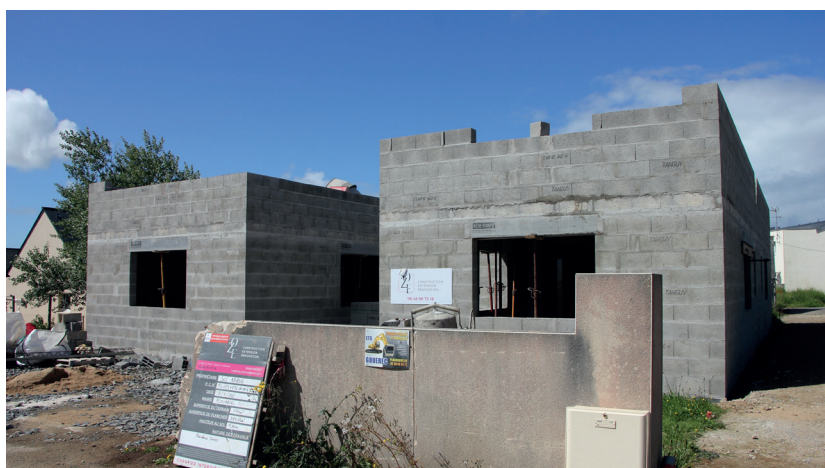
Construction en cours de la maison partagée
