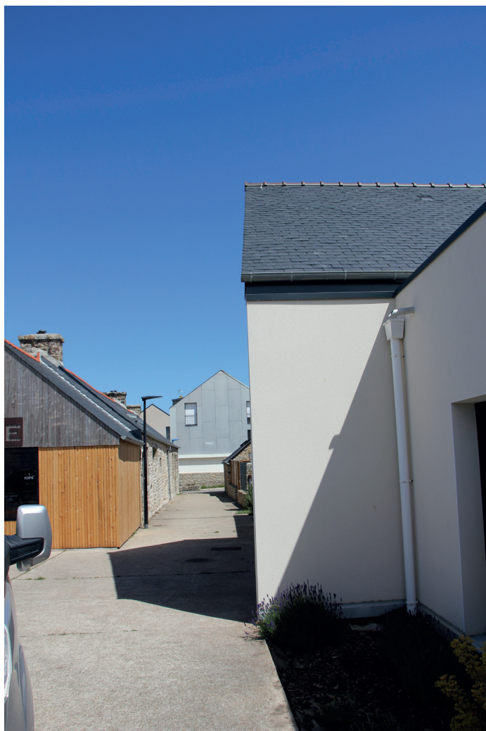
Création du chemin piéton
