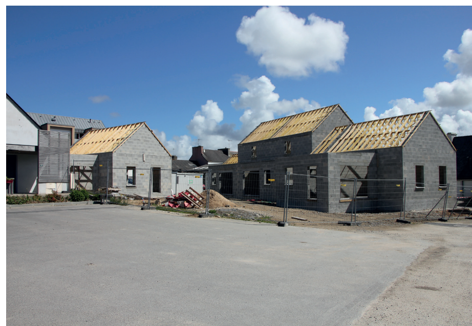
Suite de l'opération portée par les Foyers de Rennes
