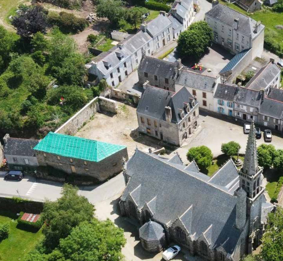
Vue du site avant travaux
