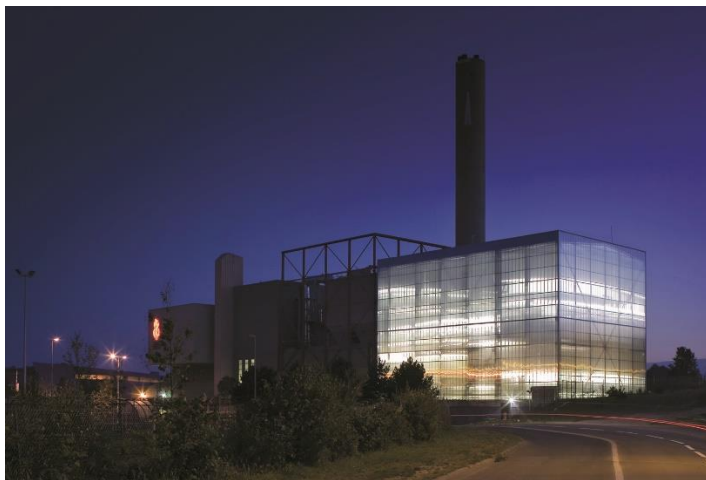
Figure 12 : Usine d'incinération SOTRAVAL de Brest
